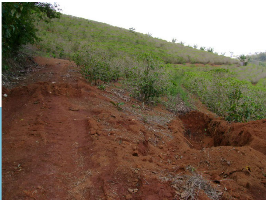
Caixa de retenção de enxurradas em cafezal
