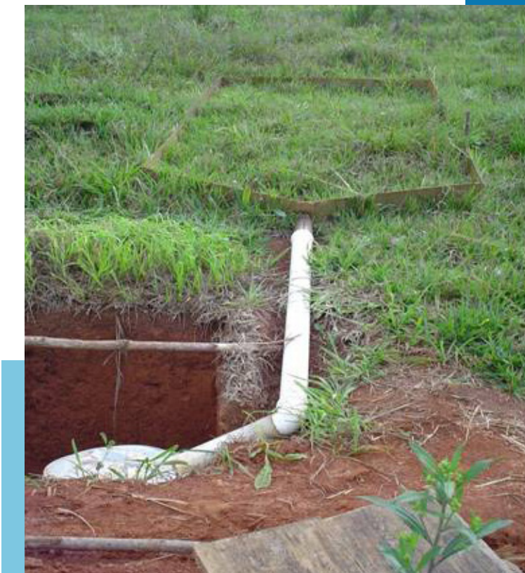
Figura 8 – Parcela de infiltração (Fonte: Valente e Gomes, 2001)
