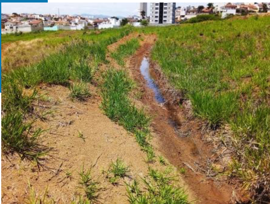
Acumulação de água em terraceamento mal nivelado. Classificada erroneamente como nascente.
